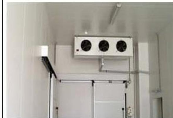
***Se gli ambienti sono ventilati basta solo iniettare l'ozono negli evaporatori o ventilatori e non necessitano di diffusori.***
